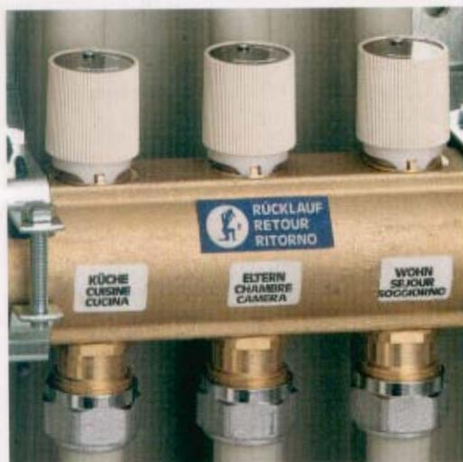
El colector de retorno está constituido por una barra de latón perforado que lleva en su interior, para cada circuito, las válvulas de interceptación.
